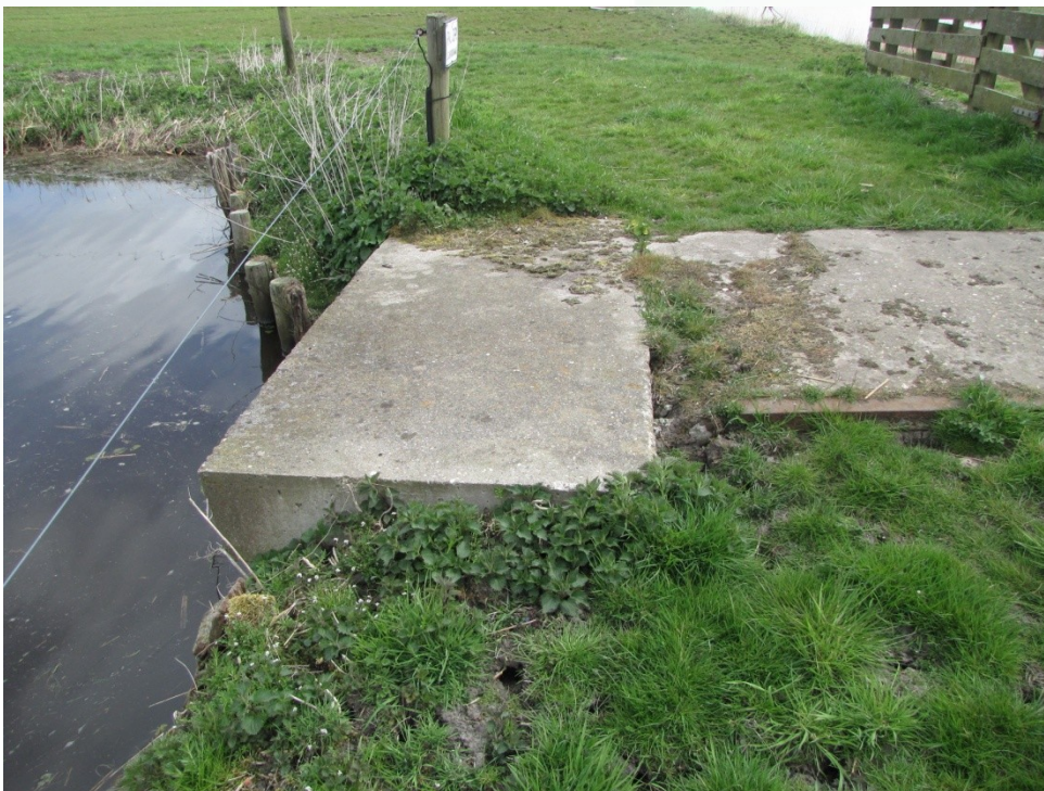
De betonnen utskoat buiten het molenerf zal in het najaar van 2015 worden vervangen.
