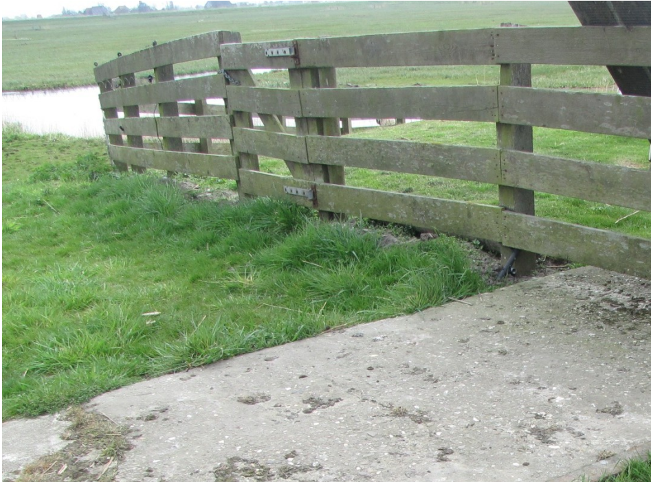
Het door houtrot aangetaste hekwerk wordt vervangen.
