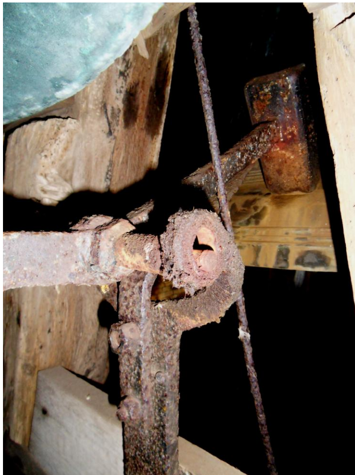
Afb.4 Slaghamer met vergaand versleten lagering
