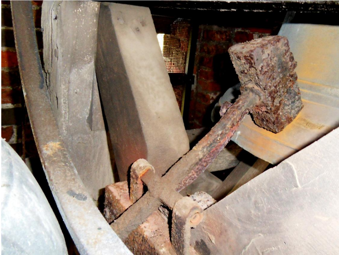
Afb. 5 Slaghamer met laging en hamerveer, geroest. Laging en hamerveer niet gesmeerd.
