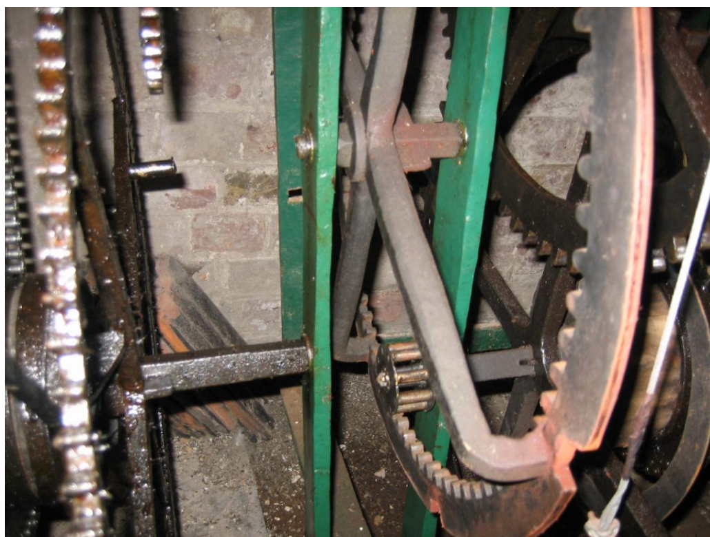
Afb.2 Sluitrad met roestvorming, niet gesmeerd
