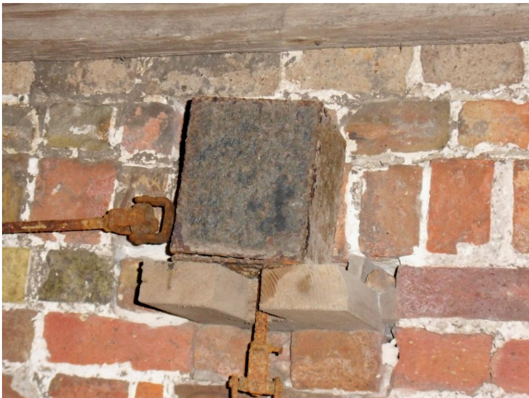
Afb.4 Beschermkastje om haakse overbrenging uuras. Koppelingen zwaar geroest en niet gesmeerd
