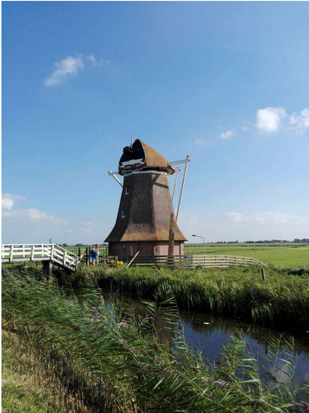
September 2016. De steiger is verwijderd.
