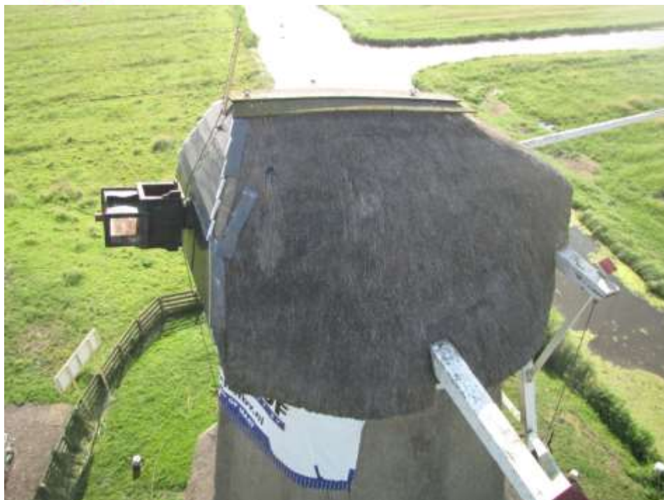
8 juni 2016. Zicht op de gebreken aan de rieten kap.
