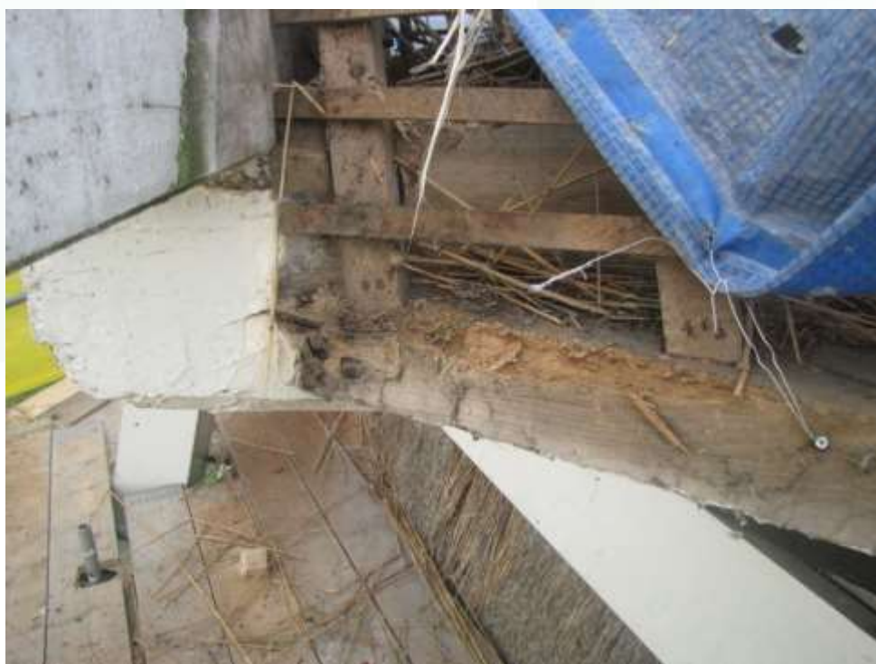
28 juni 2016. Vermolmde spantring.
