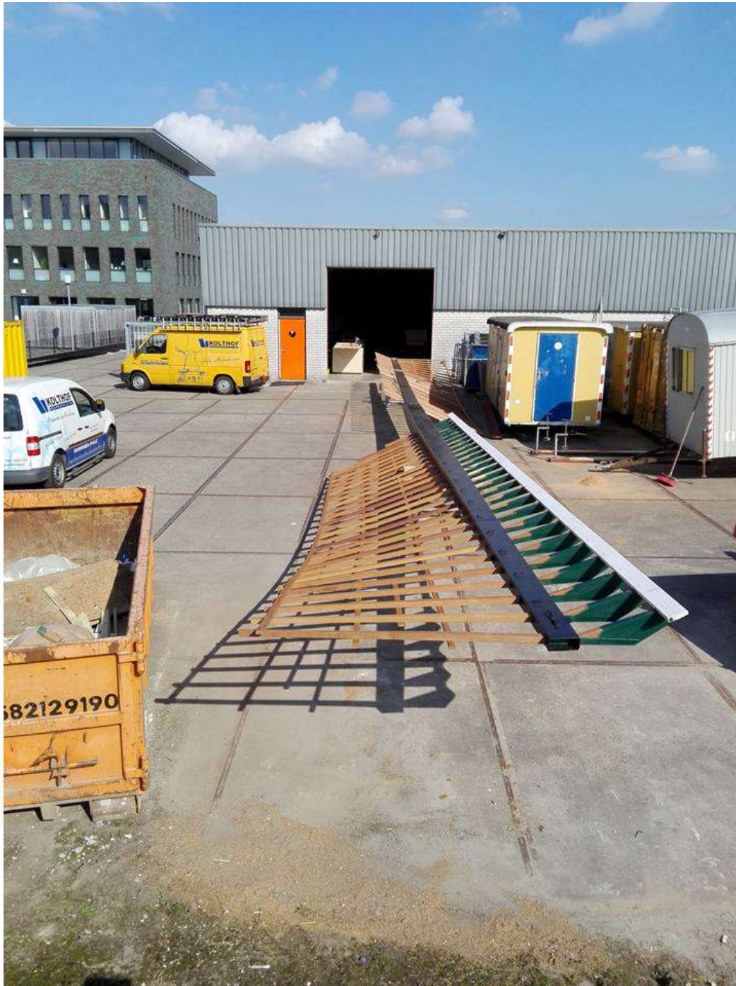
September 2016. Ophekking roeden wordt bij de werkplaats van Kolthof in Leeuwarden klaar gemaakt.
