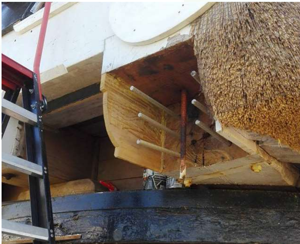
Augustus 2016 De voeghoutkop wordt met glasfiberstaven en epoxyhars hersteld.
