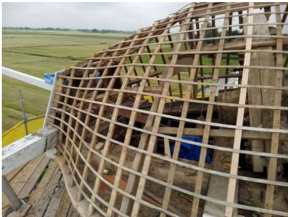
Juli 2016. Het riet is verwijderd. De rinkelatten zijn vernieuwd.
