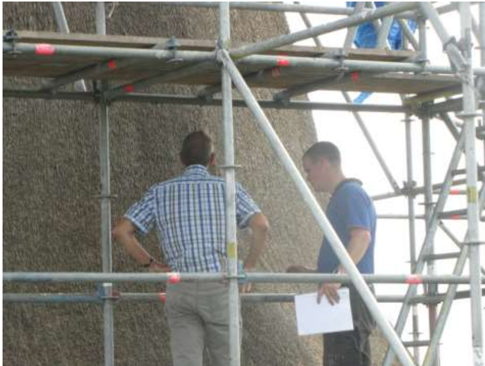
September 2016. Overleg op de steiger over rietdek achtkant.
