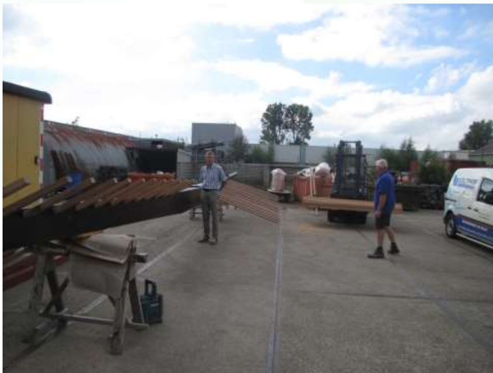
September 2016. Ophekking roeden in uitvoering.
