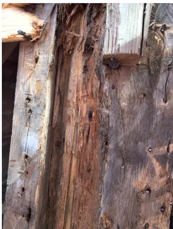
Aangetaste hoekkepers
