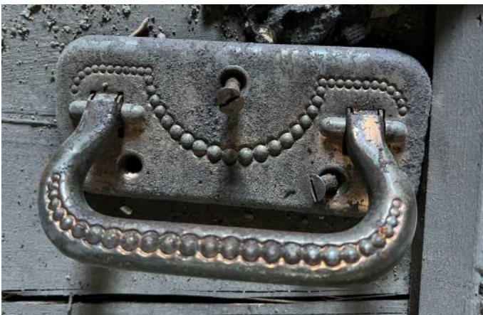
Aan beide kopeinden is één koperen handgreep gemonteerd, en aan weerszijden nog twee.
