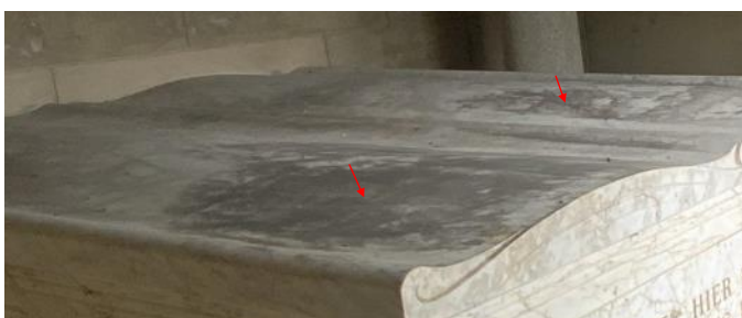
Sterk vervuilde marmeren dekplaten
