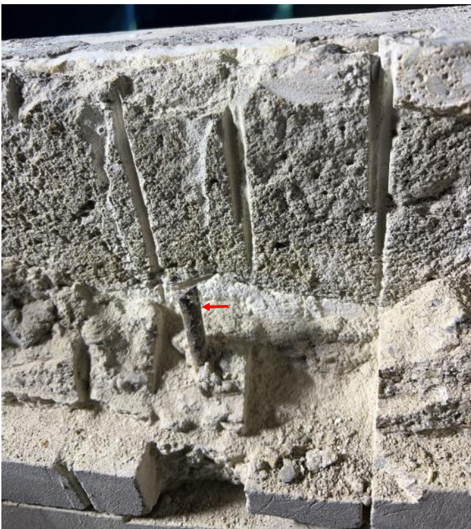
Bestaande wapening in betonwand
