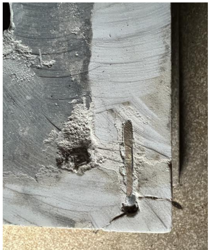
De hoek boven rechts met de koperen doek in de verbinding tussen marmeren voor- en zijwand.
