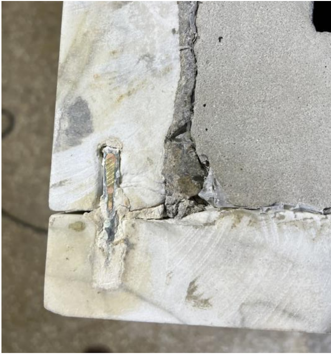
De aansluiting links voor met het nieuw aangestorte beton en de koperen doek in de verbinding tussen marmeren voor- en zijwand.
