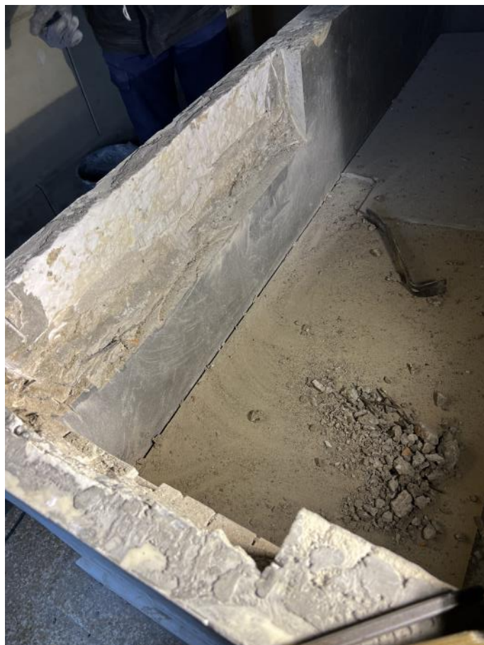
Het weggehakte deel van de betonwand waarin de scheuren voorkwamen.
