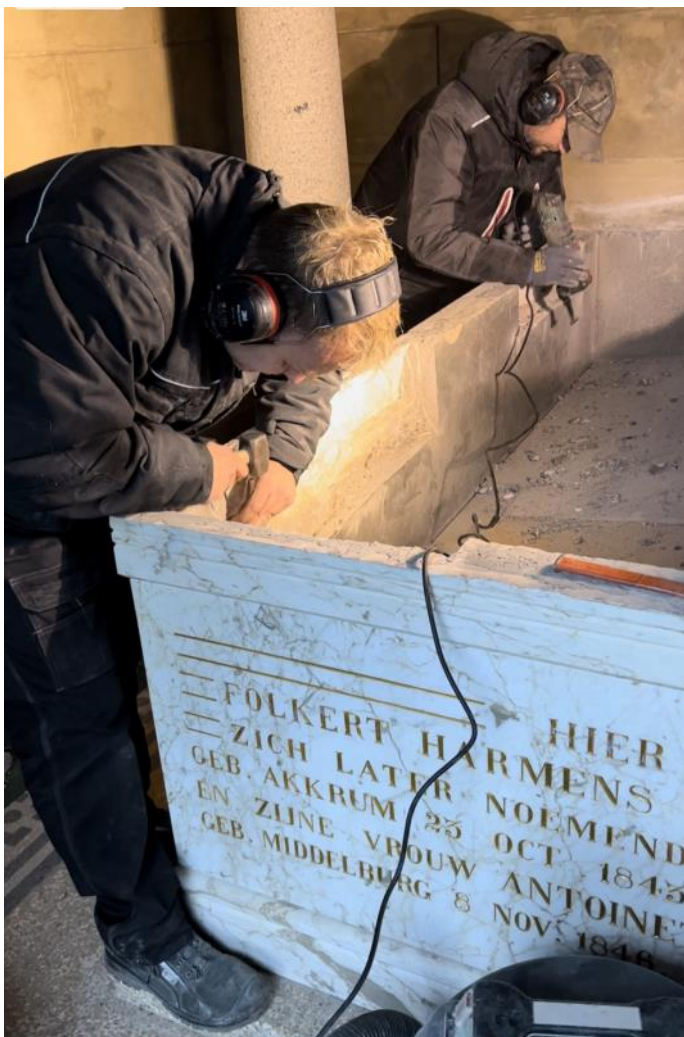
Het weggehakte deel van de betonwand waarin de scheuren voorkwamen.
