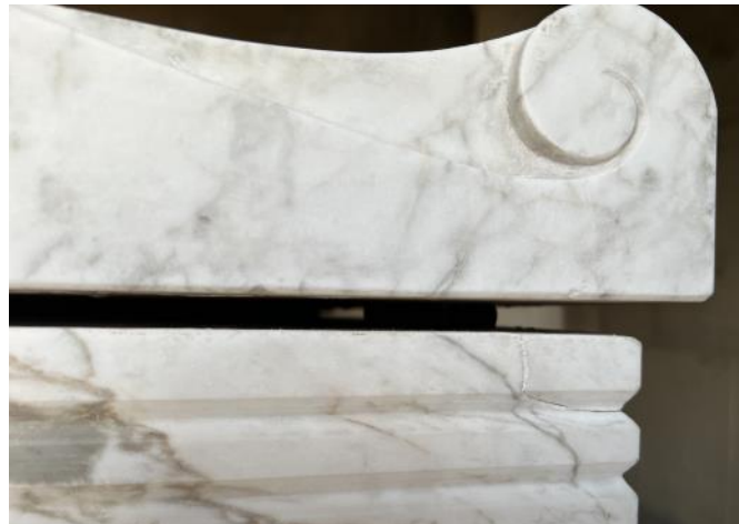
De oplegging van de dekplaten op de wanden met een loden blokje waardoor ruimte voor ventilatie ontstaat.
