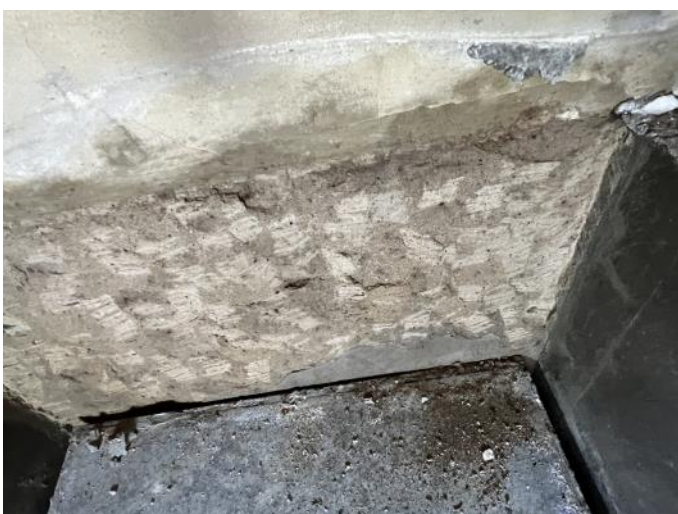
Weggehakte beton aan de kopse kant van de tombe, waarna de zinken kist precies paste.
