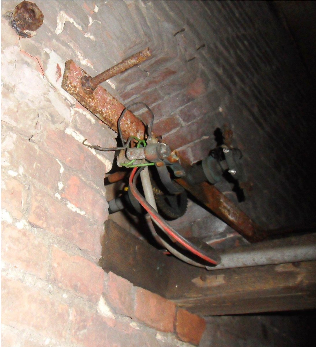
Afb.3 Motorwijzerwerk van de ingebruikzijnde wijzerplaat
