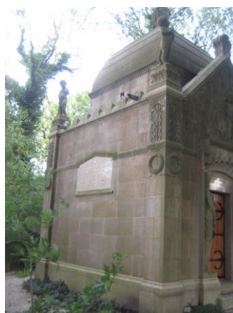
Linker zijgevel (noord).
